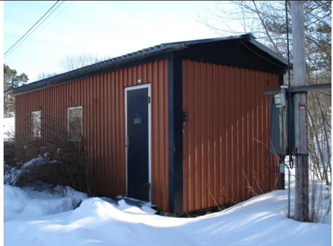
FS kontorsbarack vid Sprängberget
