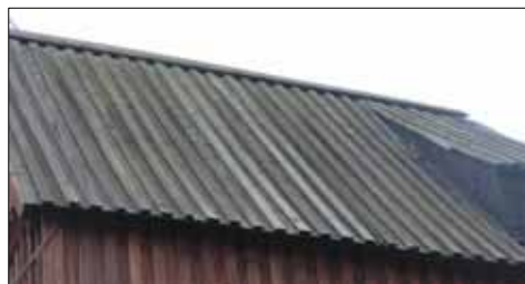
T.v. Sydöstra takfallet före renovering med kraftiga torrspäckor och med fuktskador och genomsläpp av väta som följd. Hela lockpanelen ersattes av ny dito. Nordvästra takfallet lämnades utan åtgärder, förutom strykning med Roslagsmahogny. T.h. Sydöstra takfallet efter renovering med ny brädtäckning och ny pannplåt på kvarnhjulsådan. Foto Lotta Wistrand, Stockholms läns museum 2009.
