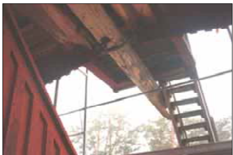
T.v. Före renovering: Den avruttnade kvarnhästen har ersatts av en ny (t.h.) i något kraftigare dimension levererad av Öhmans i Ljusdal. Foto Lotta Wistrand, Stockholms läns museum
