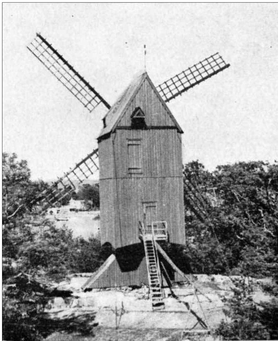
Kvarnen efter reoveringen 1961, med stagvajrar, ny ytterpanel, nya vingar, ny kvarntrappa och kvarnbro samt ny stolplåda. Ur Ester Grönblad, "Furusund ett skärgårdscentrum" (1970)
