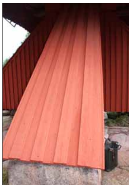
T.v. "Stubbens" täcklådor före renovering med beväxning av både grönalger och svartmögel. T.h. Täcklådorna efter renovering. Algerna är borttvättade och lådorna har målats – dessvärre har inte slamfärgen fäst vid underlaget på ett tillfredsställande sätt. Foto Lotta Wistrand, Stockholms läns museum 2009
