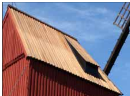
T.v. Sydöstra takfallet före renovering med kraftiga torrspäckor och med fuktskador och genomsläpp av väta som följd. Hela lockpanelen ersattes av ny dito. Nordvästra takfallet lämnades utan åtgärder, förutom strykning med Roslagsmahogny. T.h. Sydöstra takfallet efter renovering med ny brädtäckning och ny pannplåt på kvarnhjulsådan. Foto Lotta Wistrand, Stockholms läns museum 2009.
