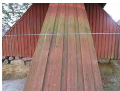
T.v. "Stubbens" täcklådor före renovering med beväxning av både grönalger och svartmögel. T.h. Täcklådorna efter renovering. Algerna är borttvättade och lådorna har målats – dessvärre har inte slamfärgen fäst vid underlaget på ett tillfredsställande sätt. Foto Lotta Wistrand, Stockholms läns museum 2009
