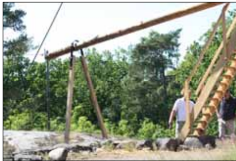
T.v. Före renovering: Den avruttnade kvarnhästen har ersatts av en ny (t.h.) i något kraftigare dimension levererad av Öhmans i Ljusdal. Foto Lotta Wistrand, Stockholms läns museum
