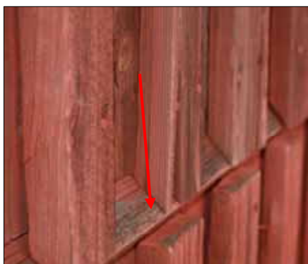
T.v. Innan renoveringen: vattbrädorna täckte ej locklisten ändträ. T.h. Vattbrädor av plåt har ersatts mot motsvarande i trä. Foto Lotta Wistrand, Stockholms läns museum 2009
