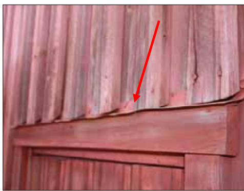
T.v. Innan renoveringen: vattbrädorna täckte ej locklisten ändträ. T.h. Vattbrädor av plåt har ersatts mot motsvarande i trä. Foto Lotta Wistrand, Stockholms läns museum 2009
