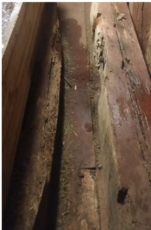
Kvarnhusets övre plan hade varit utsatt för långvarigt läckage uppifrån vingaxeln.
