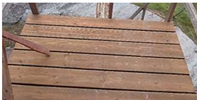
Kvarnbrons nylagda golv ströks med stubbolja. Foto Rolf Hammarskiöld 2023-10-30
