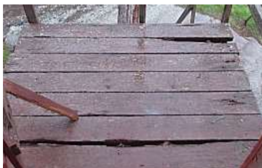
Kvarnbrons golv behövde bytas. Foto Rolf Hammarskiöld 2023-08-28
