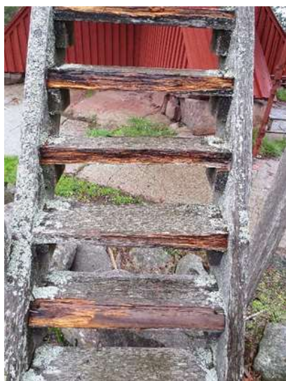
Kvarnens yttertrappa är osäker. Foto Rolf Hammarskiöld 2023-08-28
