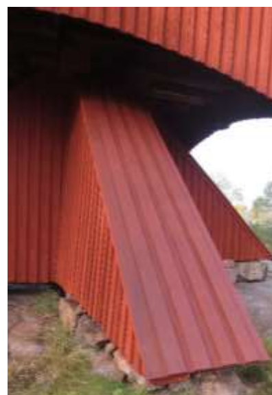
Ovansidorna på kvarnstubbens täcklådor glänste av stubbolja 2023-10-30. Foto Rolf Hammarskiöld
