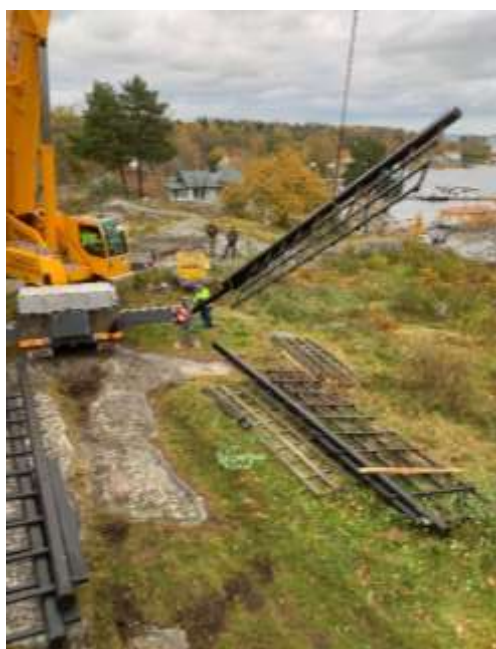
Nya kvarnvingar monterades. Foto Ola Lundqvist 2023-10-26
