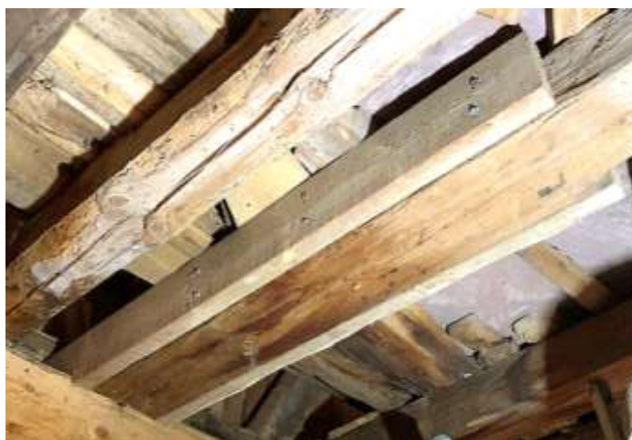
I kvarnens mellanbjälklag sattes stämp under en skadad stock, innan den förstärktes med plank. Foto Ola Lundqvist.
