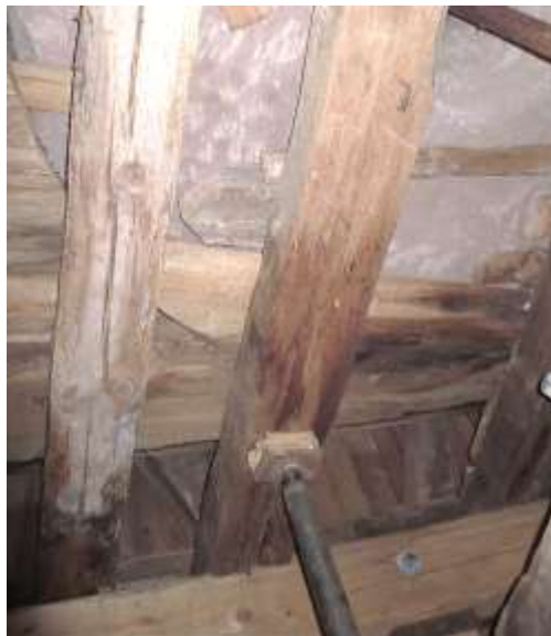
I kvarnens mellanbjälklag sattes stämp under en skadad stock, innan den förstärktes med plank. Foto Ola Lundqvist.
