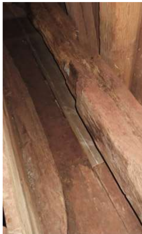
Kvarnhusets övre plan hade varit utsatt för långvarigt läckage uppifrån vingaxeln.
