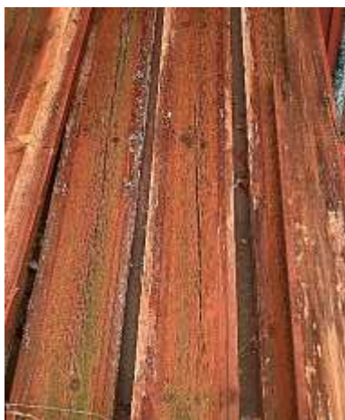
Panelen på underredets sydöstra snedsträva var utsliten, så den ersattes med ramsågade bräder från kvarnens förråd.
