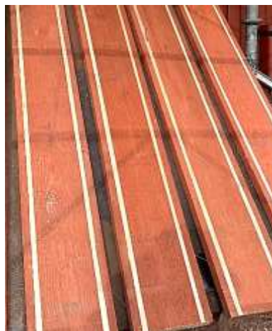
Panelen på underredets sydöstra snedsträva var utsliten, så den ersattes med ramsågade bräder från kvarnens förråd.
