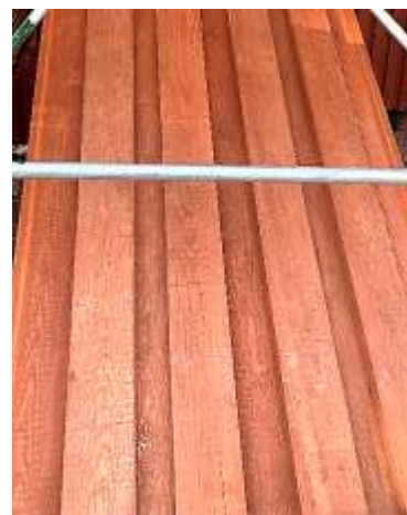
Panelen på underredets sydöstra snedsträva var utsliten, så den ersattes med ramsågade bräder från kvarnens förråd.
