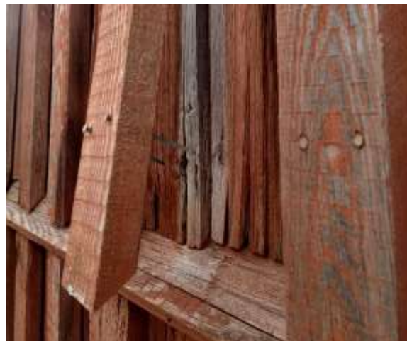
Fasadpanelen har torrsprickor, men lär hålla många år till. Locklister satt löst därför att spikarna var för klena.
