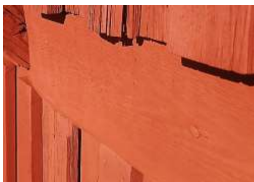
Uttjänt splintved på en våningsskiljande balk höggs bort och ersattes med en bit plank, som sattes fast med tillvaratagen gammal klippspik och smidd spik.
