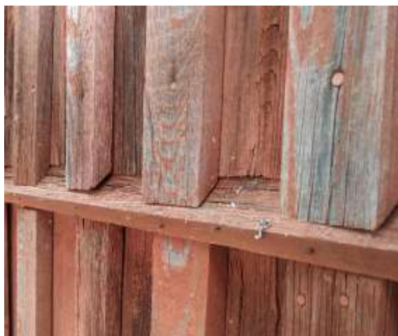
Fasadpanelen har torrsprickor, men lär hålla många år till. Locklister satt löst därför att spikarna var för klena.
